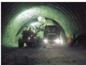
トンネル坑内ずり運搬ダンプはバックモニター装備車を使用し、バック運転時の安全確保を行いました。
