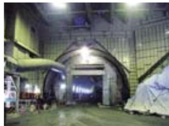
起点側防音扉をトンネル上下線に各 1 基設置し、トンネル発破振動騒音の低減を図りました。
