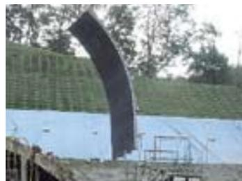
坑門工外型枠に鋼製支保工と型枠を一体化したユニット型枠を採用し、平滑で仕上がりの良いコンクリートを打設できました。
