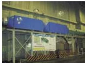
坑口に設置してある送風機は消音機（サイレンサー）搭載型とし、騒音の低減を図りました。
