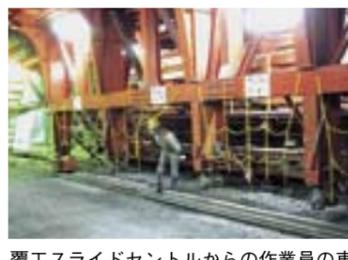
覆工スライドセメントからの作業員の車道への飛び出しによる作業車両との接触事故防止設備を考案しました。（平成 14 年度事故災害防止提案として土工協関東支部及び鉄建協東京支部より佳作表彰を受けました）
