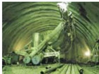
低土被り部の沢部で長尺先受け工法を採用し、沢の水をトンネル内に流入させることなくトンネル掘削を行いました。
