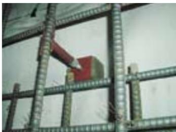
覆工コンクリート鉄筋組立でコンクリートの流動性を考慮した鉄筋組立治具を開発しました。
