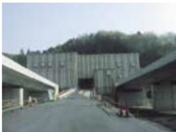
起点側防音ハウスを設置し昼夜間作業におけるトンネル作業騒音の低減を図りました。
