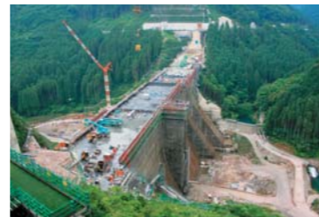
■ 工事概要 工事件名：大山ダム建設工事 工事場所：大分県日田市 工期：2007.4.21～2013.3.19 ダム形式：重力式コンクリートダム
