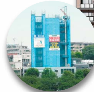
2010年7月の現場状況
