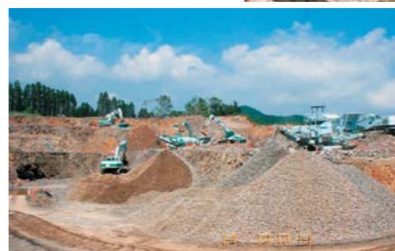
仮設備の配色の配慮
