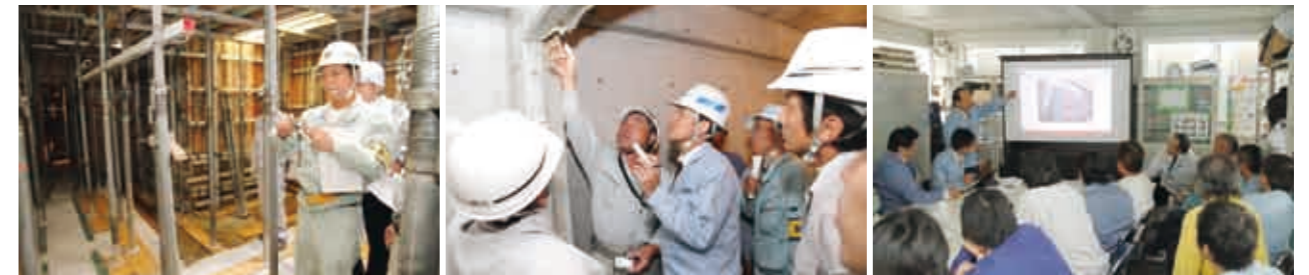
左/通路の安全性をチェック。また、この現場では型枠の一部をプラスチック型枠にして外光を採りいれています 中/パトロール側も施工側も、熊谷組も専門工事業者も、ものづくりへの真剣なまなざしは変わりません 右/各自が撮影した現場画像をプロジェクターで投影しながら検討会
