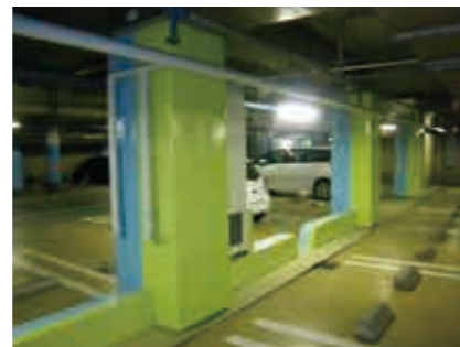
鋼板巻立て補強完了（柱）
