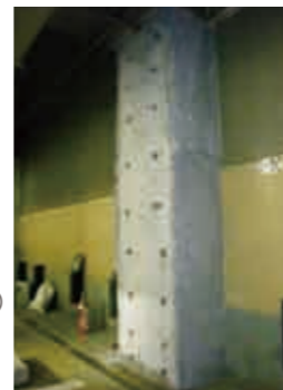
一面耐震補強（側壁）
