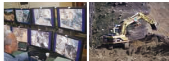
マシンコントロールシステムを使って操作室から無人の重機を操作し、作業している状況
