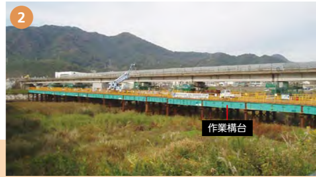
②支承を取り替えるには橋桁を一度上げなければならず、橋とほぼ同じ長さの作業構台を組んでジャッキで押し上げて取り替えた。また落橋防止のズレ止めストッパーを設置
