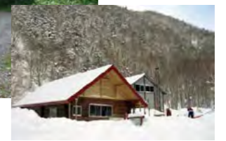
完成したヒュッテ（手前）
