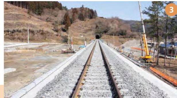
③【2013.3.9取材時】線路完成。法面工事は続けられている
