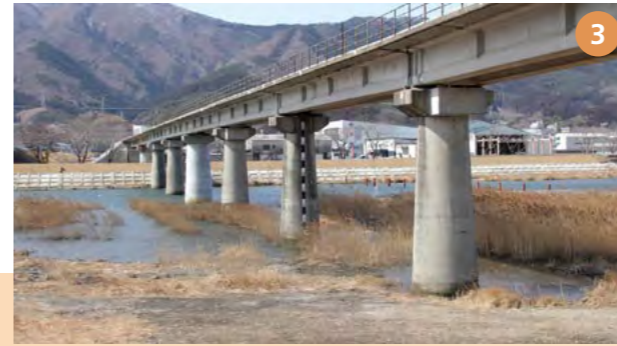
③【2013.3.9取材時】修復完成。橋脚2本は外側を鉄筋コンクリートで巻立て補強
