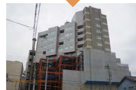
低層部を建設、上層部と接続
