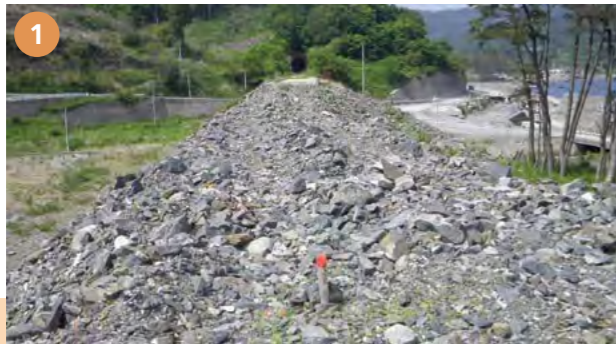
①【着工前】線路などすべてが津波で流された後に、かき集められたがれきが積み、どこにどう線路を通すのかまったくイメージできない状態
