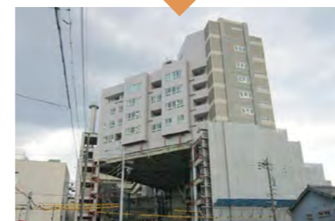
病棟機能を上層部に移し、既存病棟を解体
