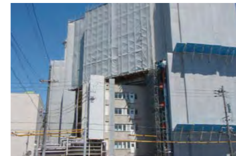
既存病棟上空に跨いで上層部を建設
