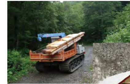
重機で資材を運搬
