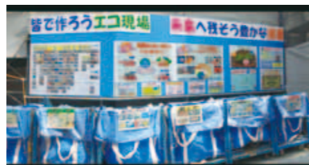
現場での分別 リサイクルしやすくするために廃棄物の種類ごとに分別し、再び資源として利用します
