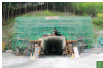
1 八雲第1トンネル終点側坑口。2014年4月に貫通し、これで4本のトンネルすべてが貫通した。まずここを140m掘り、そこを資材置き場にして第2トンネルを一気に掘った
