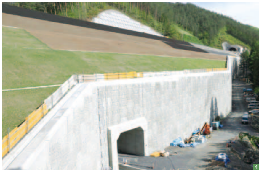
4 大規模な盛土と補強土擁壁を築造。擁壁は最高壁高19.5mで、近くに行くと見上げるばかりの高さ。右奥上に八雲第3トンネル坑口が見える
