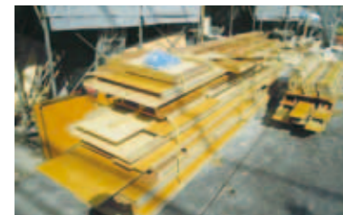
型枠合板材のプレカット 現場で使う大きさに工場でカットした物を現場に納入します。これにより端材が出なくなり、ゴミは発生しません
