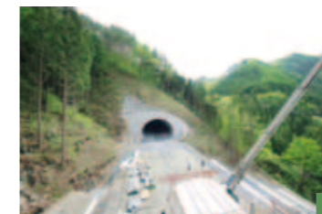
2 八雲第2トンネル終点側坑口。4本の中では最長のトンネルで、県道とJR山田線の直下を通過する。2013年10月に貫通
