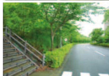
ネッコチップ工法 現地発生土と伐採木を破砕した生のチップ材をリサイクルすることにより、在来植生の復元、生態系の保全を可能にした緑化工法です。写真上は施工状況、下は施工から12年後の状況
