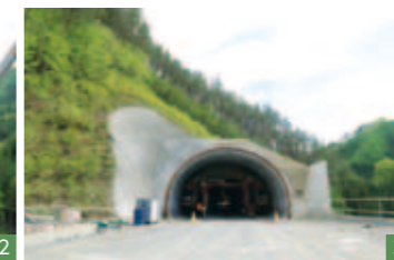
3 八雲第3トンネル終点側坑口。上部に山の神を鎮め、工事の安全を祈願する化粧木（けしょうぎ）が見える。最短のトンネルで、2014年2月に貫通
