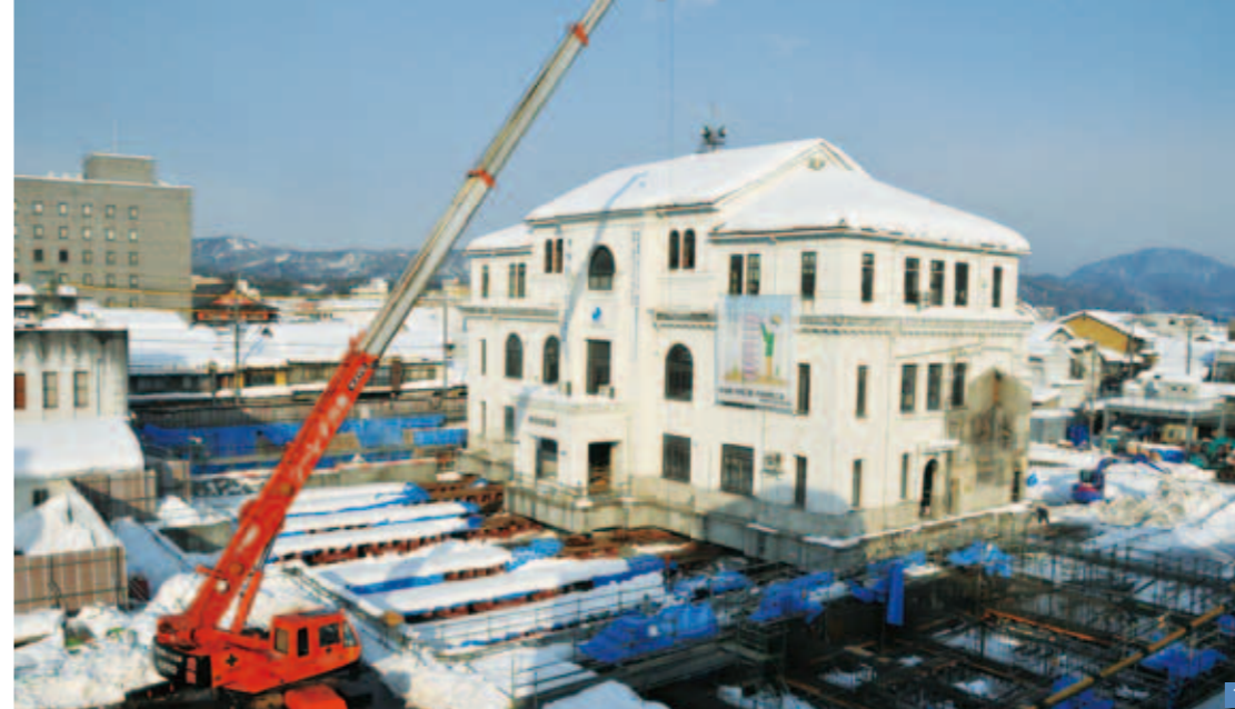
1 曳家風景(2012年2月)。レールに積もった雪をクレーンで取り除き、推進ジャッキで30cmずつ押し出して移動させました。曳家作業は全5日間に市民に公開。「しっかり見ていただくため、安全対策には相当気を配りました」と安田所長 2 市民の曳家見学会。公募により参加した皆さんは、コロ棒が回転して建物が動いていく様子を見学。思わず「おおー!」と声が上がります 3 新庁舎。改修された旧本庁舎を、新築の7階建て庁舎がコの字に囲みます。兵庫県主催の「人間サイズのまちづくり賞」で2013年度まちなみ部門賞知事賞を受賞しました
