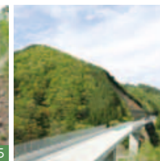
6 県道、水海川、JR山田線をまたぐ水海高架橋の上部工。JVのオリエンタル白石が施工し、2013年7月に連結式が行われた
