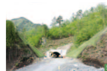
5 水海トンネル起点側坑口。2013年10月に貫通。坑口左右の山を切り拓いた斜面は、網で押さえて植生基材を吹き付け、今は美しい緑の壁になっている
