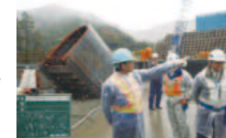
本社現場点検
